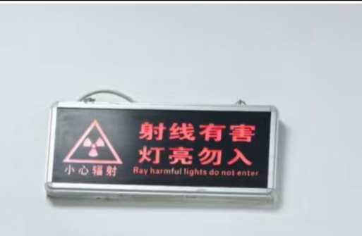
工作状态指示灯箱及门灯连锁装置
